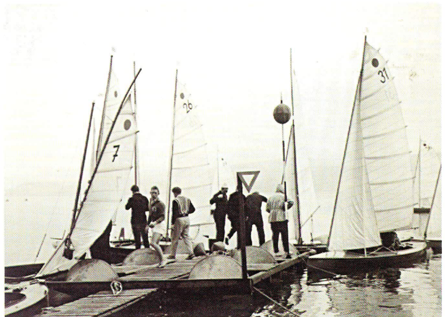
Der Steg an der Möhne wurde in Eigenarbeit errichtet.
